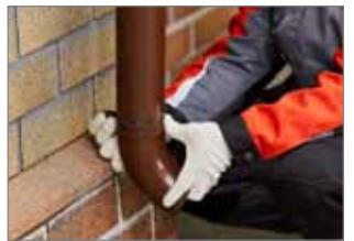
**8.** Заканчиваем монтаж системы установкой слива. Фиксируем его хомутом.
