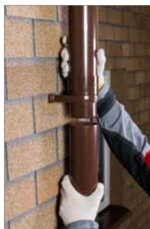
**13.** Соединение водосточных труб между собой производится при помощи соединительной муфты, которая фиксируется на фасаде при помощи хомутов.
