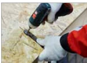
**1.5.** Если шаг кронштейнов не совпадает с шагом стропил, прямой удлинитель или металлический кронштейн закрепите прямо в деревянное основание в заранее подготовленные углубления.
