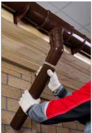
**11.** В случае наличия карнизного вылета для соединения воронки с водосточной трубой используйте два универсальных колена и отрезок трубы, подрезанный на требуемую длину. На нижнее колено обязательно установите хомут.
