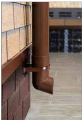
**14.** Установите водосточный слив на трубу и зафиксируйте его хомутом. При этом минимальное расстояние слива от грунта — 200 мм, от отмостки — 150 мм.
