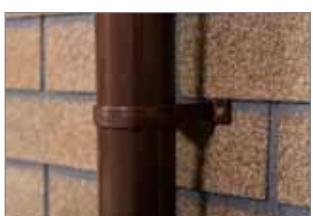
**12.** Водосточные трубы крепятся к основанию здания при помощи хомута крепления трубы. Шаг хомутов составляет не более 1,5 м.
