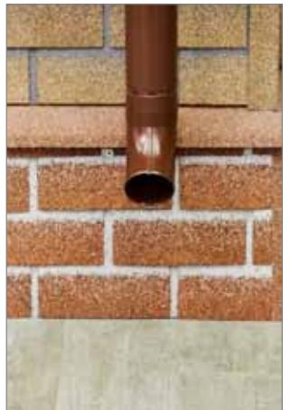
**8.1.** Минимальное расстояние слива от земли — 20 см, при наличии отмостки — 15 см от уровня отмостки. Слишком низкое расположение водосточного слива к земле повышает риск образования наледи внутри трубы, что может ухудшить работоспособность всей системы и привести к разрыву трубы.
