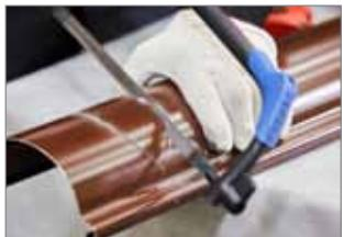
**3.1.** Вырежьте отверстие в желобе при помощи ножовки по металлу и ножниц по металлу. Соедините воронку с желобом и зажмите фиксаторы.
