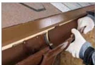
**4.** Вставьте желоба внутрь воронки до обозначенной линии. Соединение желоба с воронкой необходимо производить в направлении «изнутри наружу»: от внутренней стороны желоба (от фасада здания) к внешней до защелкивания с фиксирующим элементом воронки.
