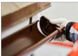
**6.** Если крыша двухскатная или система водостока не замкнута, торцы желобов нужно закрыть заглушкой. При установке подогните одно «ухо» заглушки со стороны лобовой доски. Заглушка универсальная, подходит для установки с обоих краев желоба.
