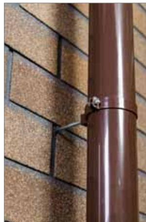
**a)** Установите дюбель в несущую часть фасада. Механический крепеж хомута подбирается в соответствии с отступом от фасада и толщиной теплоизоляции и должен заходить минимум на 50 мм в несущую конструкцию.
