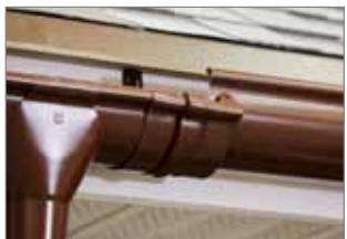
**4.1.** В кронштейны уложите желоб с воронкой изнутри наружу. Зажмите фиксаторами при помощи специального ключика, который идет в комплекте.
