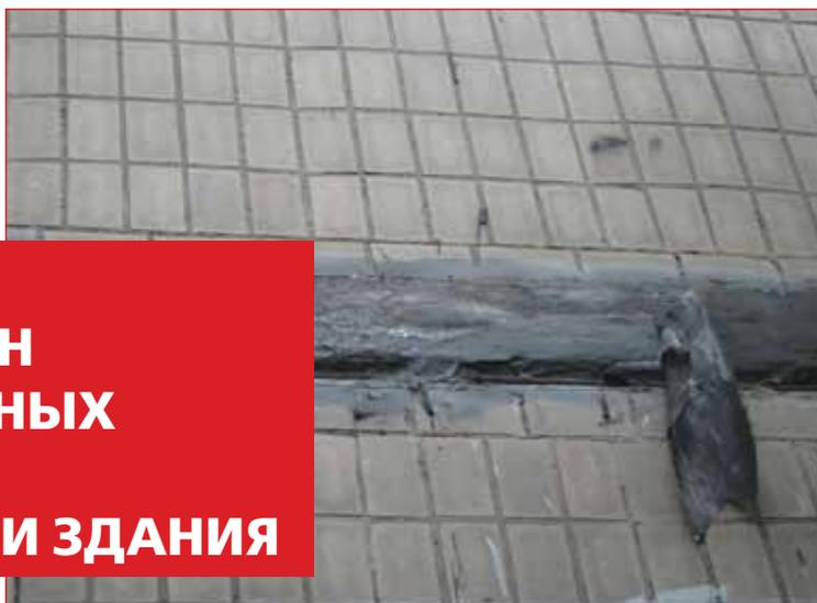
Сопряжение железобетонных панелей с перекрытиями и в углах изолируют уплотнительной прокладкой и герметиком №45 (рис. 10, 11 и 12).
